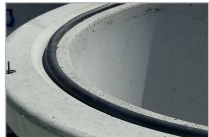
Mettre en place le joint Torique dans la rainure.
