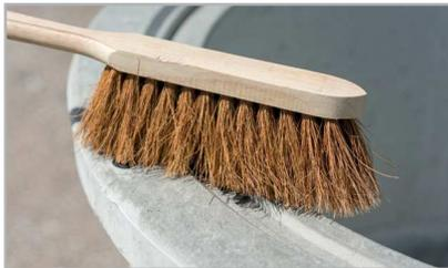
Éliminer les traces d'humidité et de poussière de la surface d'appui du joint, ainsi que sur l'emboîtement mâle de l'élément supérieur.
