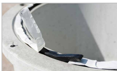
Mettre en place le joint Butyl dans la rainure et ôter la protection.
