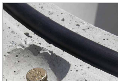
S'assurer que le joint Torique est bien tendu et épouse bien les rebords.
